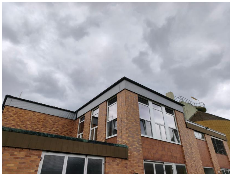
Bereits ausgetauschte Fenster
